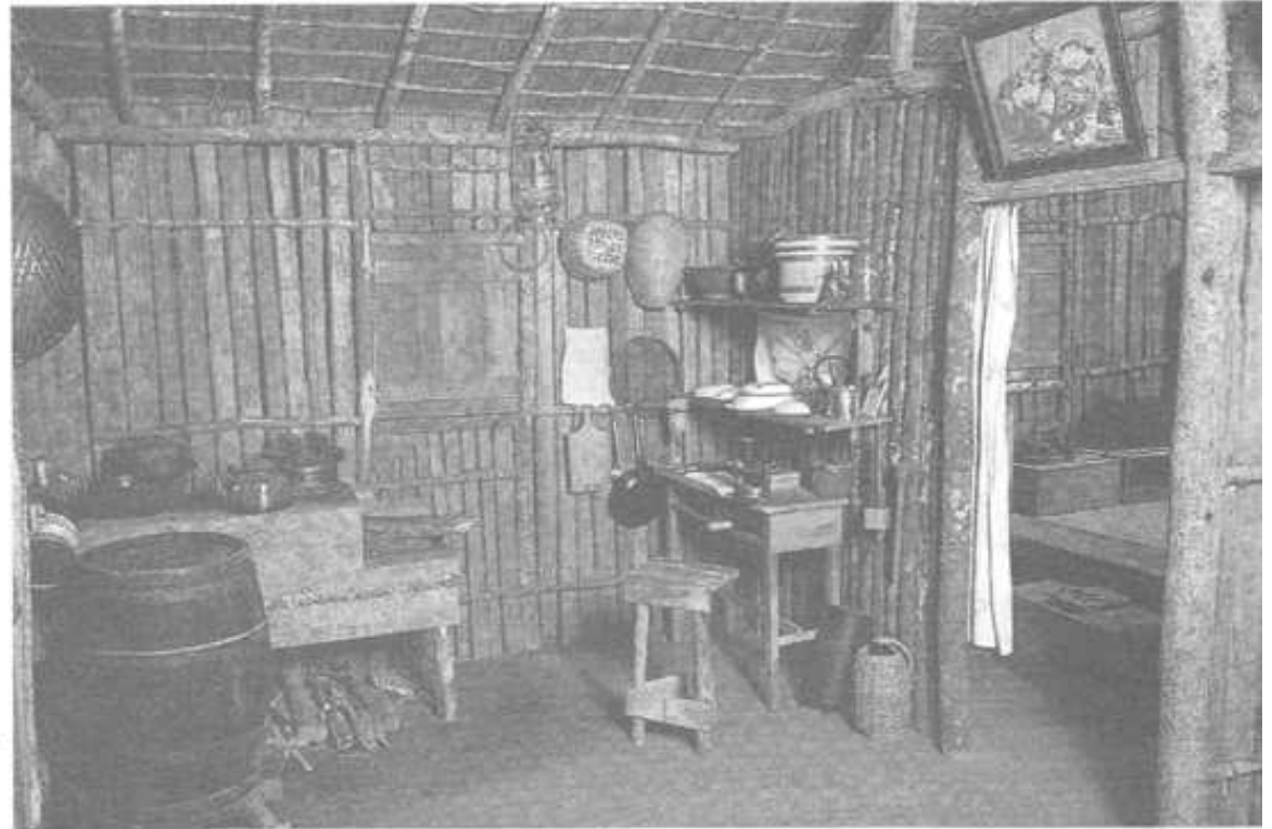
70年祭のメイン事業として建設された移民史料館で人気がある開拓小屋内部。
