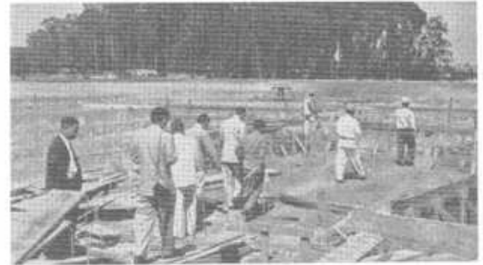
1954年4月、日本館資材と共に棟梁・左官が到着（上）、 54年3月26日、日本技師団の現場下検分（下）。
