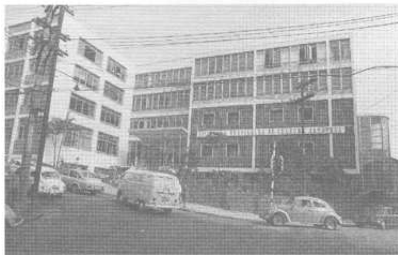
62年3月31日、第1期A・B工事とも一部を除いて完了した。
